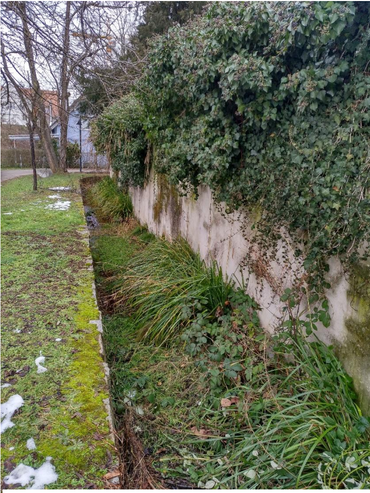
Abb. 3 Westseite der Mauer mit Graben.
